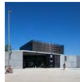
Médiathèque grand M / Atelier d'architecture King Kong
