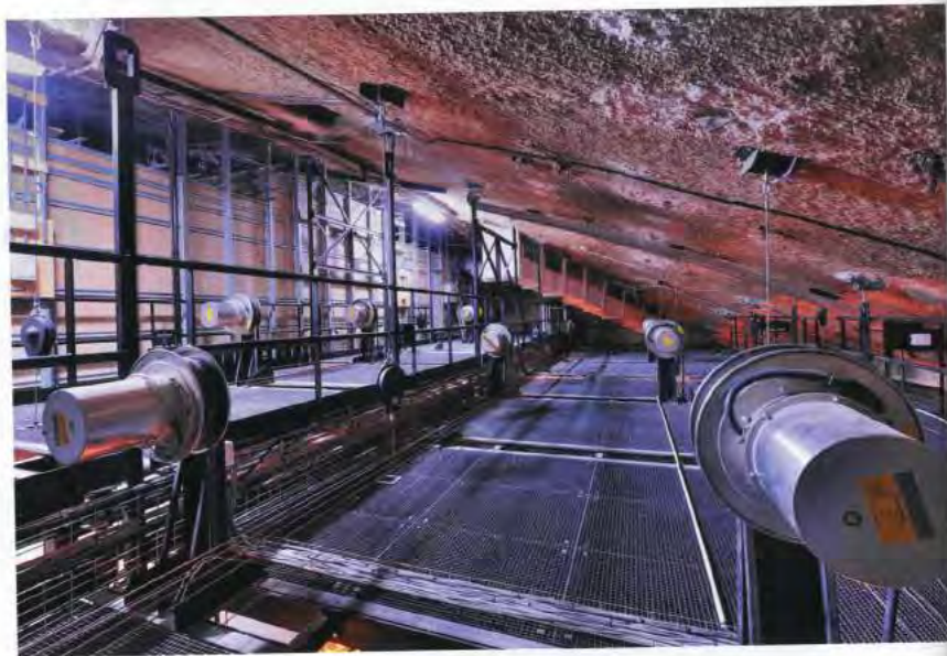
Gril de scène encastré au niveau le plus bas du dôme
