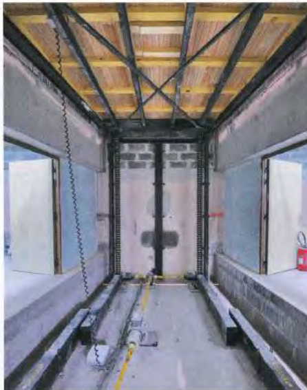
Élévateur d'orchestre monte-piano (avant-scène centre)
