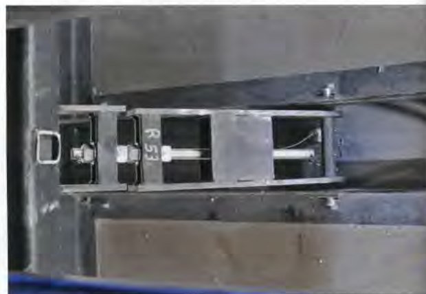
Dispositif de réglage manuel de l'inclinaison des réflecteurs de la canopée
