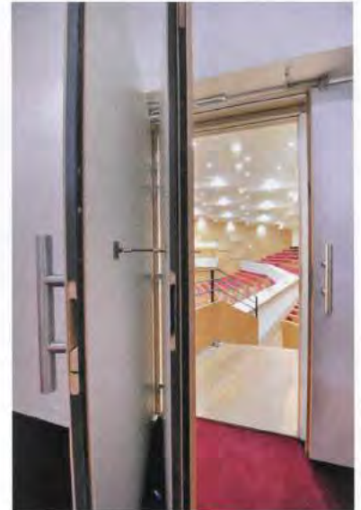
Double porte acoustique du balcon haut (lorsqu'un un sas traditionnel n'est pas envisageable)
