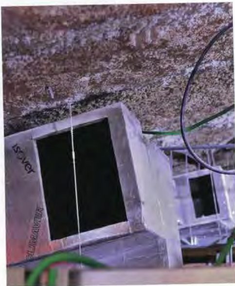
Interstice dôme/décor : gaine en matériaux non métallique ; bouche sans grille
