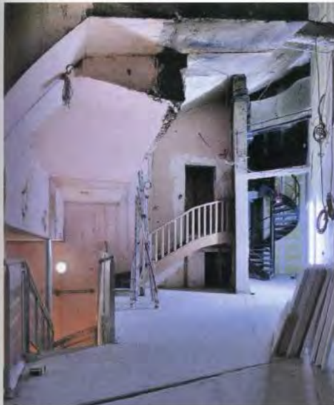
Ici on mesure la réduction de la largeur de la salle ; à gauche : le mur d'origine ; à droite : le mur du décor acoustique
